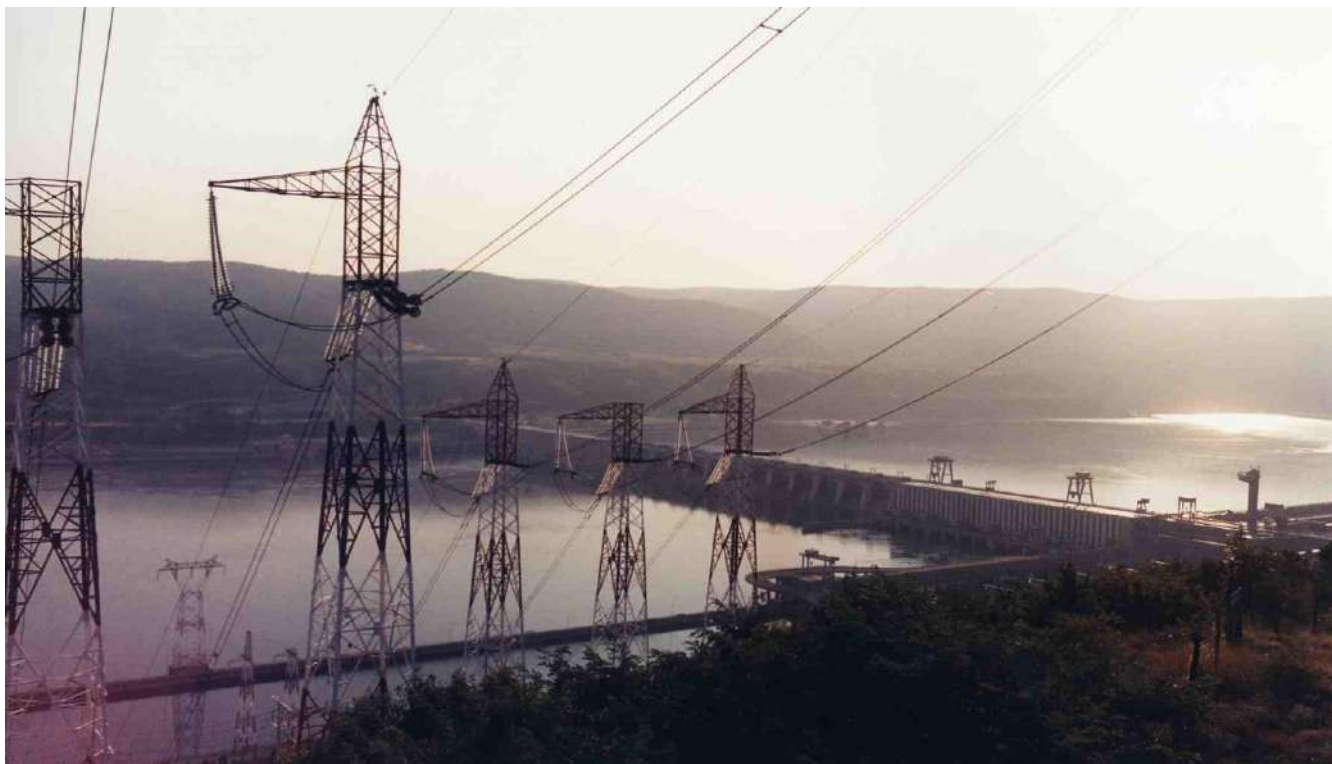
Foto: Prima arteră de 400kV din Sistemul Energetic Național–Linia Electrică Aeriană 400kV, simplu circuit, CHE Porțile de Fier – București Sud
