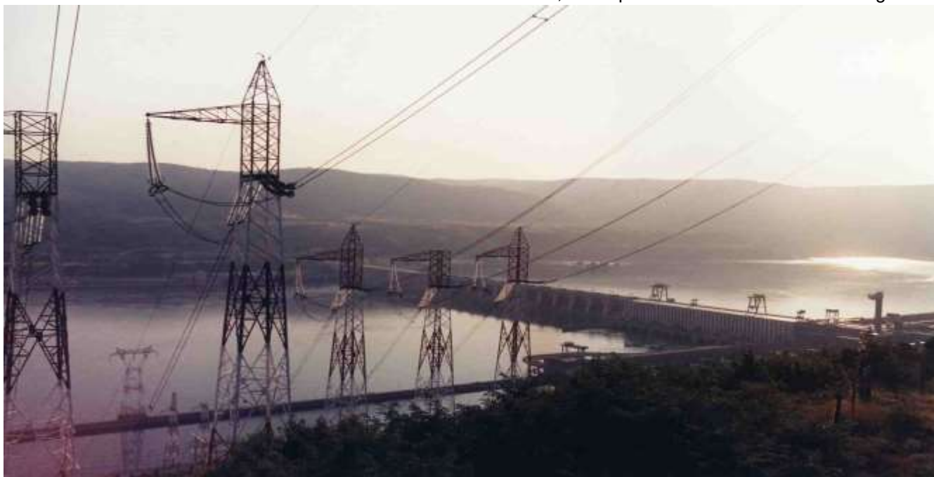
Foto: Prima arteră de 400kV din Sistemul Energetic Național – Linia Electrică Aeriană 400kV, simplu circuit, CHE Porțile de Fier – București Sud
